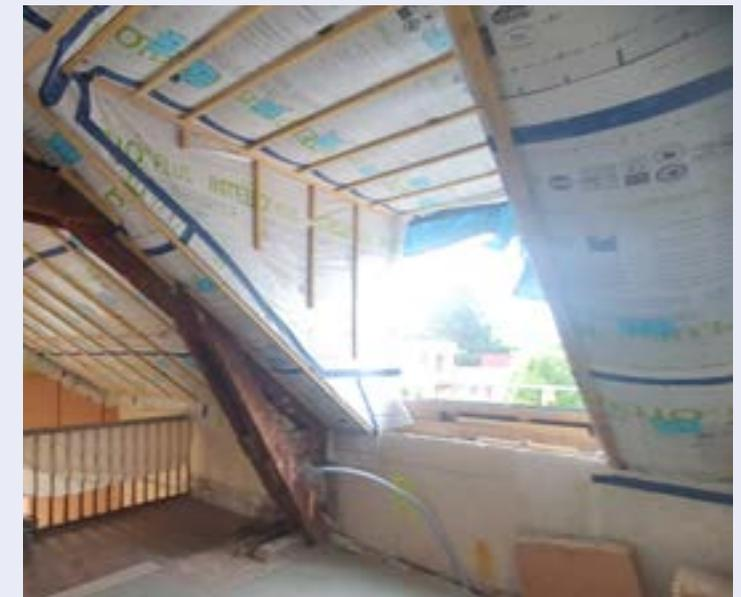
Procédé de mise en œuvre d'une jacobine avec isolation sous rampant - Chantier Na architecture
