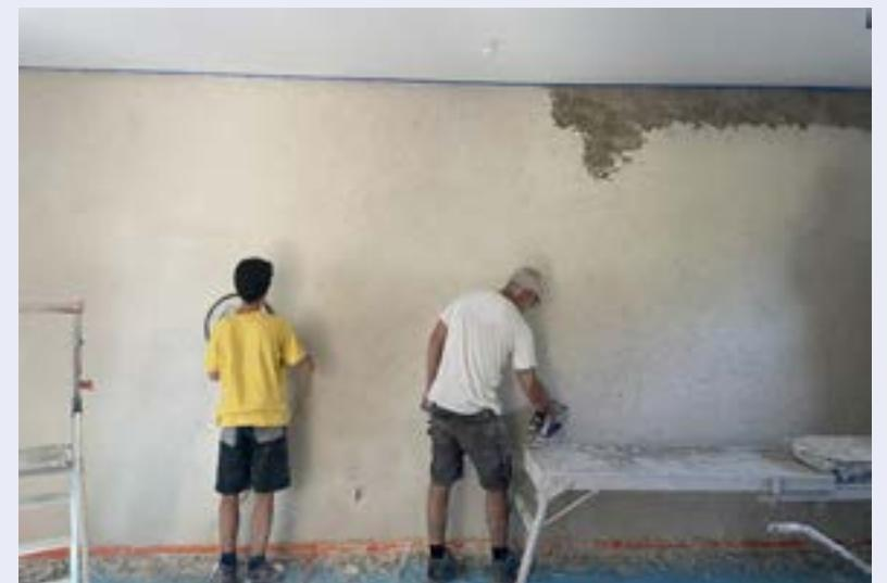
Procédé de mise en œuvre d'un correcteur thermique chaux-chanvre et de son enduit de finition à la chaux - Chantier NA architecture
