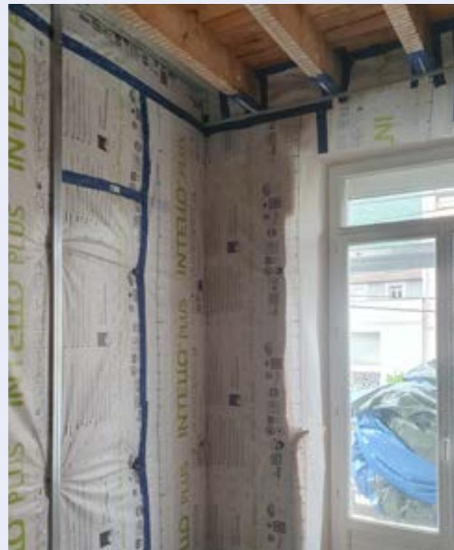
Procédé de mise en œuvre d'une isolation par l'intérieure avec frein vapeur - Chantier NA architecture
