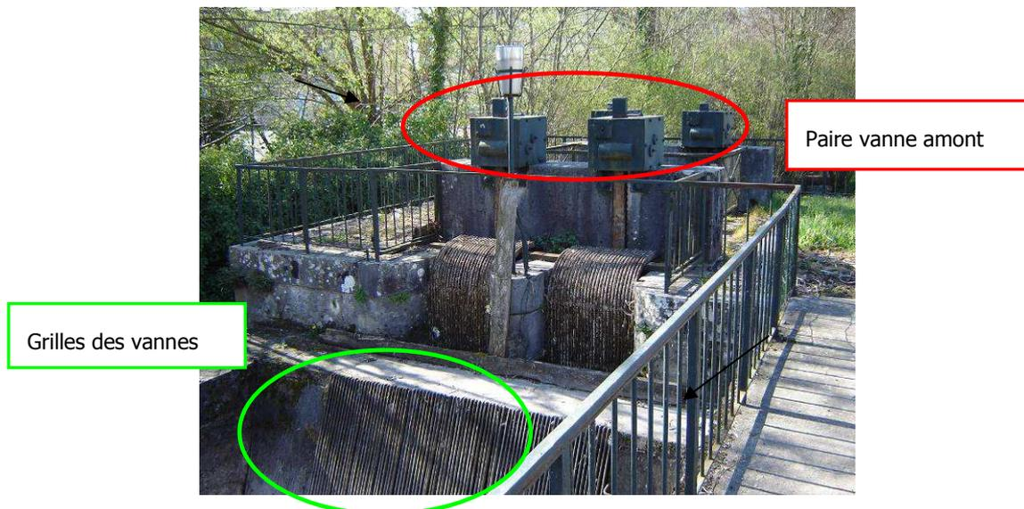
**Figure 17 : Ouvrage des vannes du Lac de Paladru**
